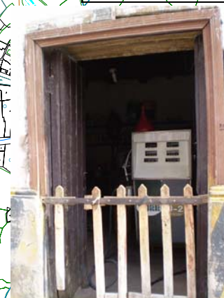
Grifos funcionando en viviendas
